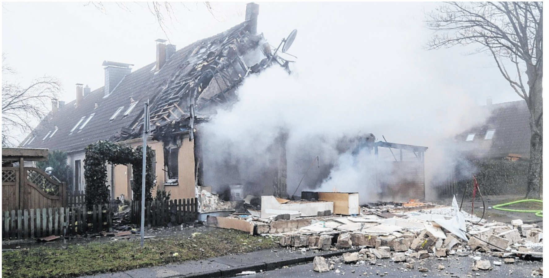
Das Reihenendhaus in Nortorf wurde durch die Explosion komplett zerstört.
